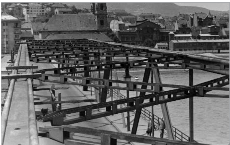
Öt hónap alatt épült fel az első »állandó« átkelő, a Kossuth híd – 1946.
