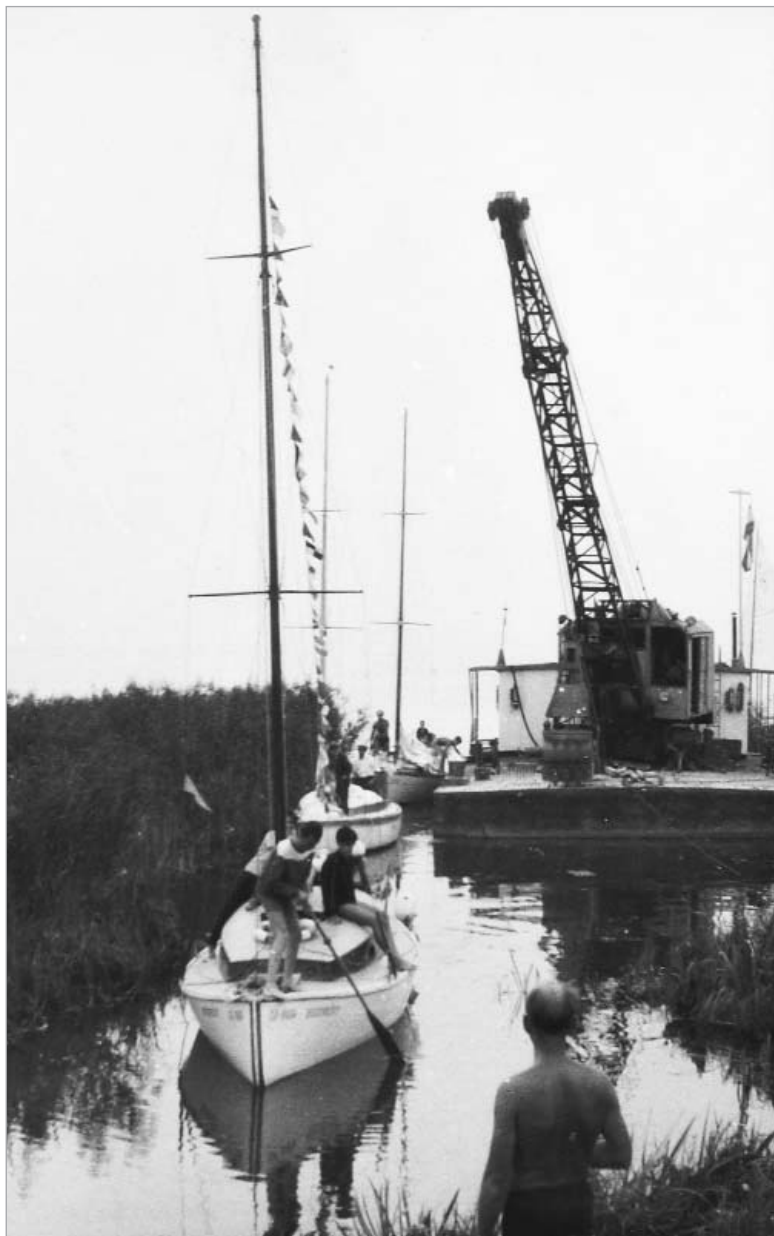
Ünnepi felvonulás után hazatérőben – 1966.
